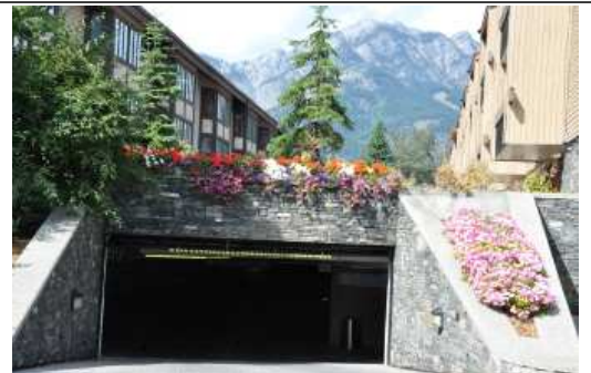
주차장 진입구 조경 작업
